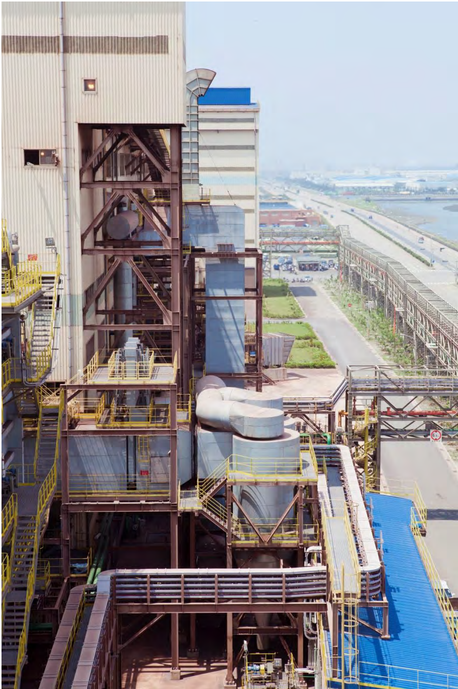
Primetals Technologies による選択式排ガス再循環（SWGR）システム
